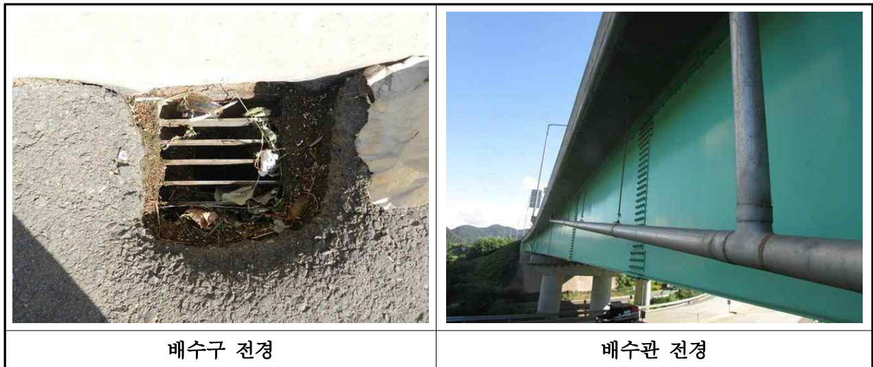
【사진 3.2.16】 배수구 및 배수관 전경(대구)
