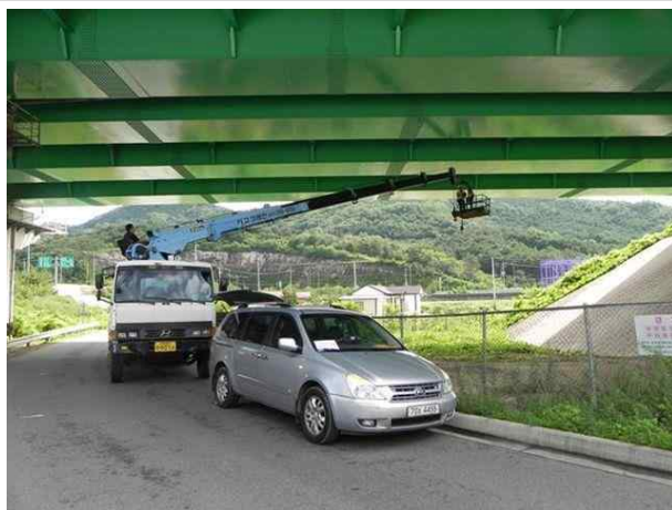
고소작업차를 이용한 조사
