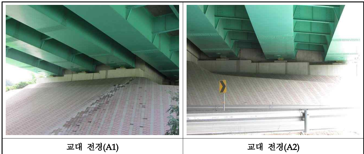
【사진 3.2.5】 교대 전경(대구)
