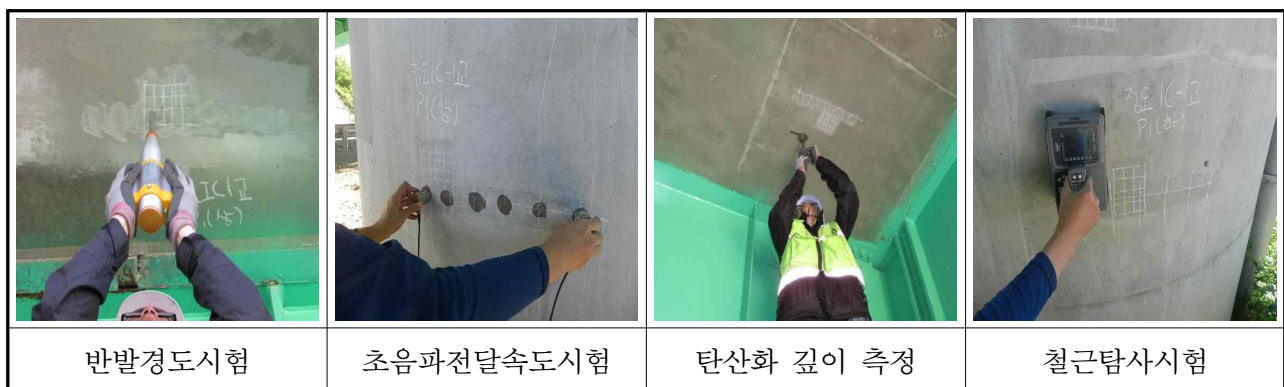
【사진 3.4.1】 콘크리트 내구성조사 전경
