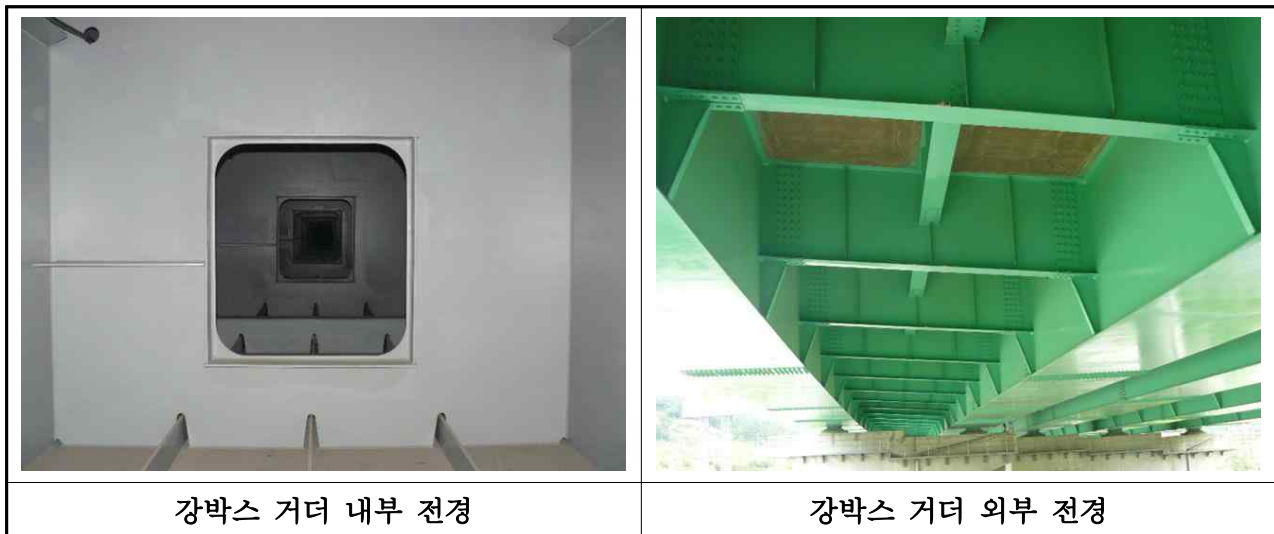
【사진 3.3.2】 강박스 거더 전경(부산)
