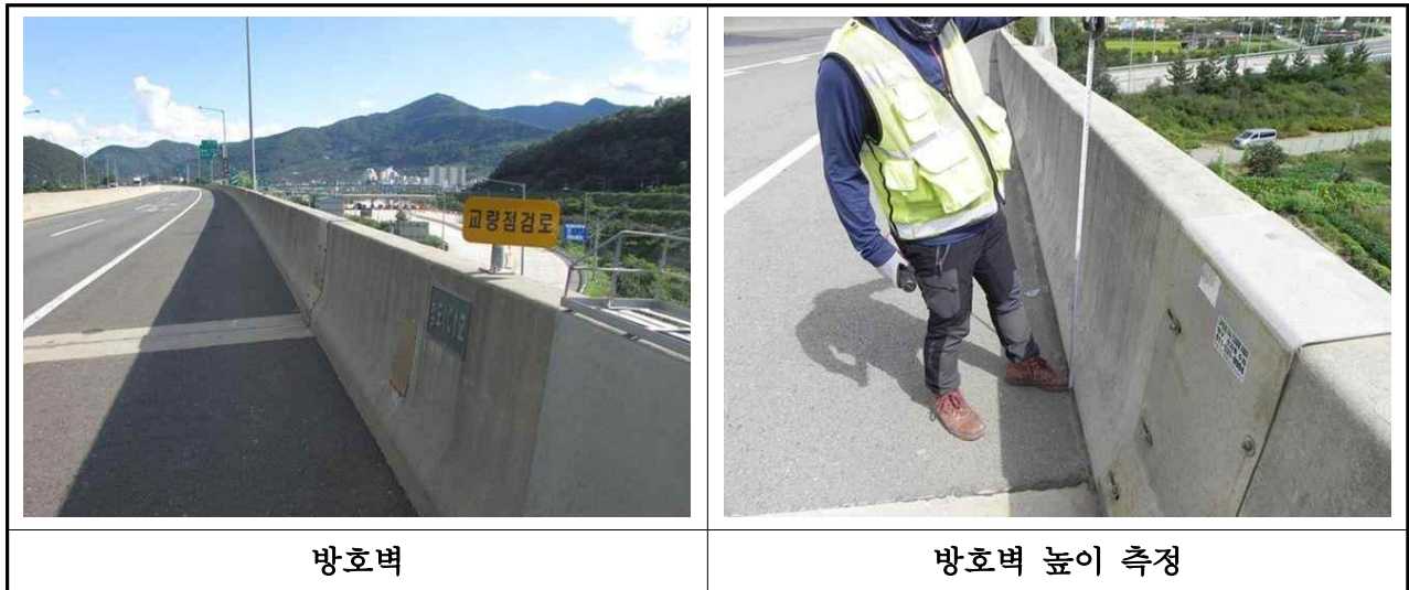
【사진 3.3.18】 난간 및 연석 전경(부산)
