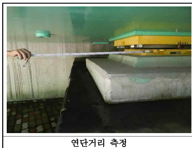
【사진 3.2.10】 연단거리 측정 전경(대구)
