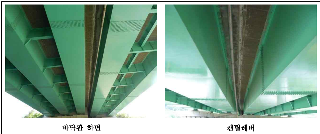
【사진 3.3.1】 바닥판 전경(부산)
