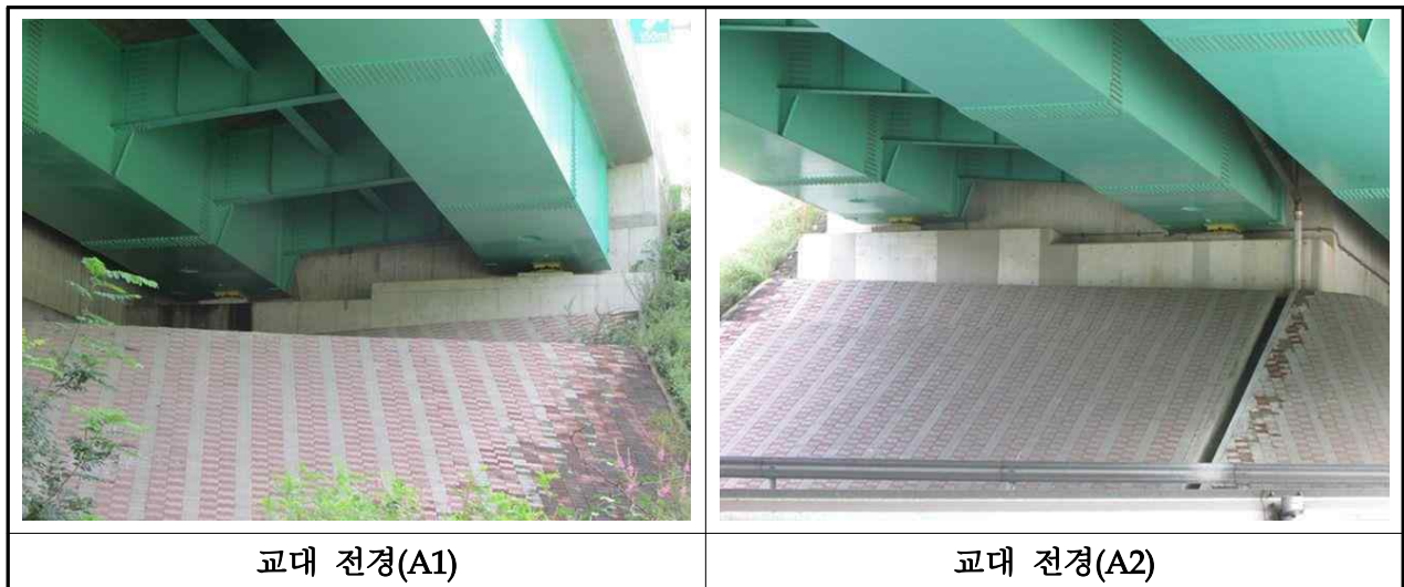
【사진 3.3.4】 교대 전경(부산)
