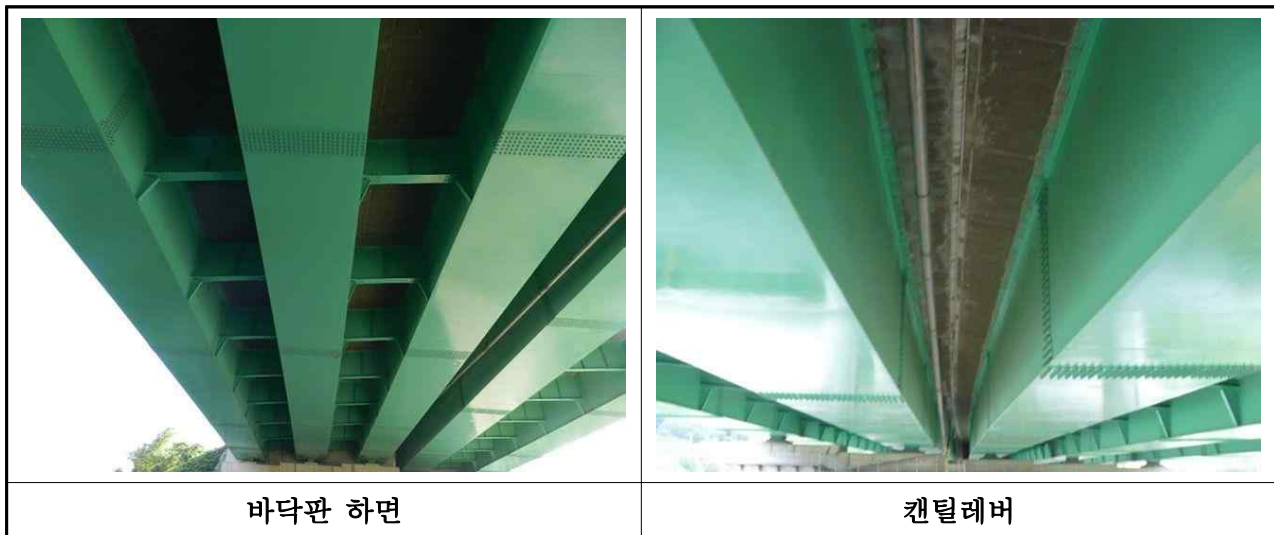
【사진 3.2.1】 바닥판 전경(대구)
