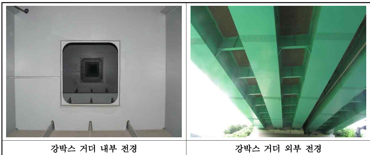
【사진 3.2.2】 강박스 거더 전경(대구)
