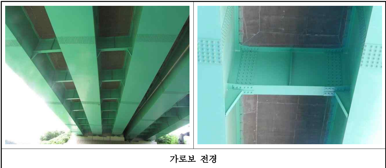
【사진 3.2.4】 가로보 전경(대구)
