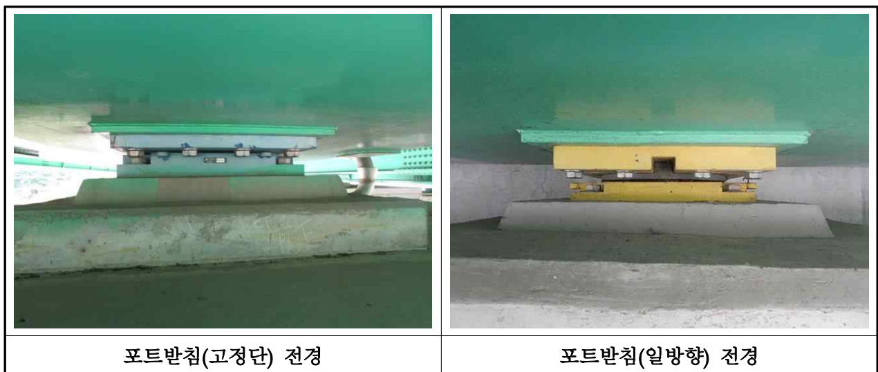
【사진 3.3.8】 교량받침 전경(부산)
