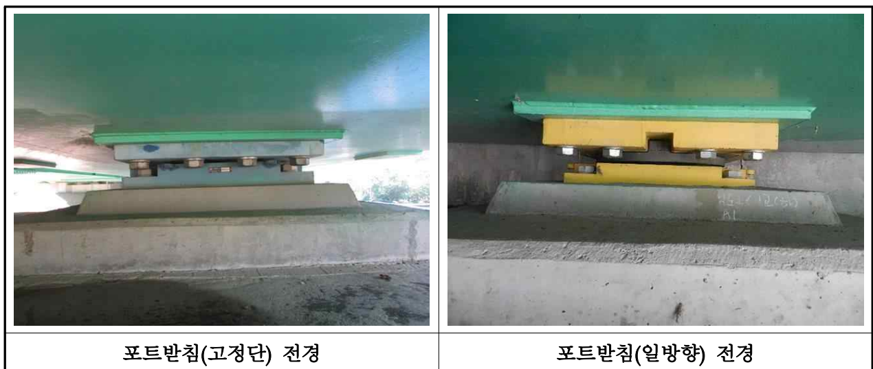
【사진 3.2.9】 교량받침 전경(대구)
